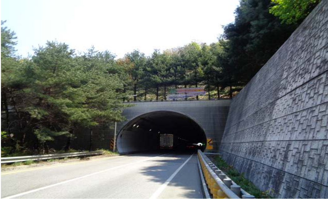
오천터널(하행선) 외부 전경
