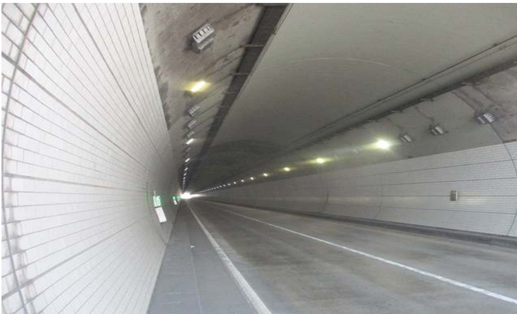
오천터널(하행선) 내부 전경
